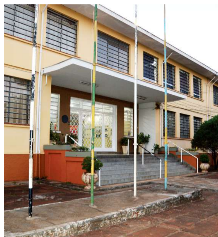
Escola 'Sinharinha Camarinha', onde está o elevador para deficientes
